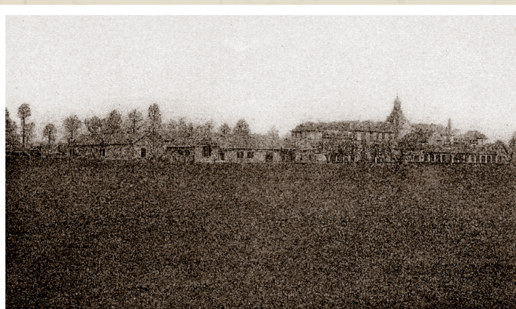
Vue générale de l'École et de la ferme en construction (début des années 20)
